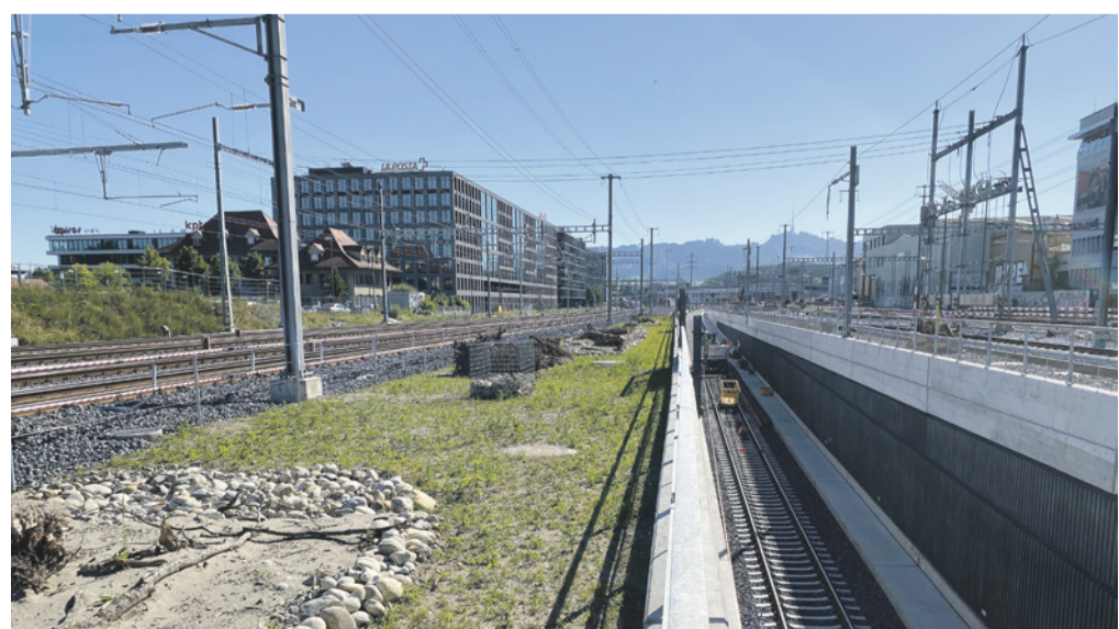
Infrastruttura ferroviaria: l'aumento del traffico rende necessario decongestionare gli snodi ferroviari come Wylerfeld (BE). Altrove, potrebbe essere necessario aspettare.
