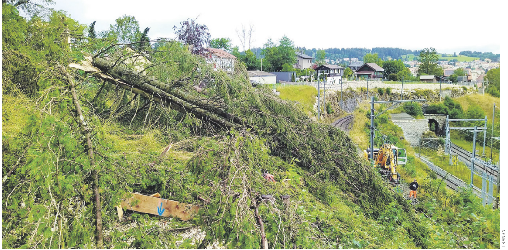
Sia i bus che i treni di TransN sono stati colpiti pesantemente dalla tempesta. A sinistra la linea della Itigne La Chaux-de-Fonds - Les Ponts-de-Martel.
