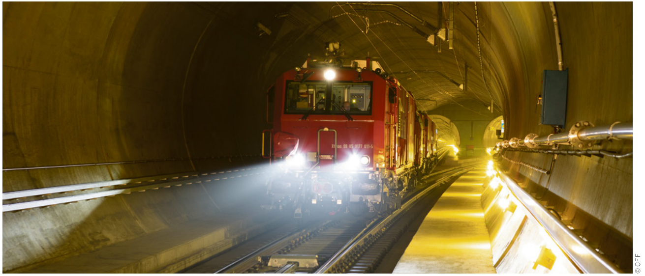
Train d'extinction et de sauvetage (TES) dans le tunnel de base du Saint-Gothard.
